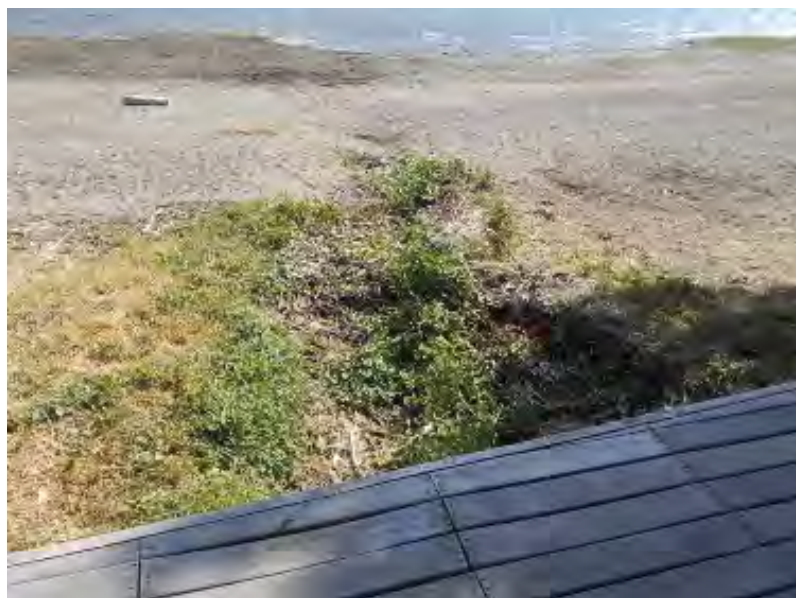
Foto N° 22. Pluvial calle Brown
