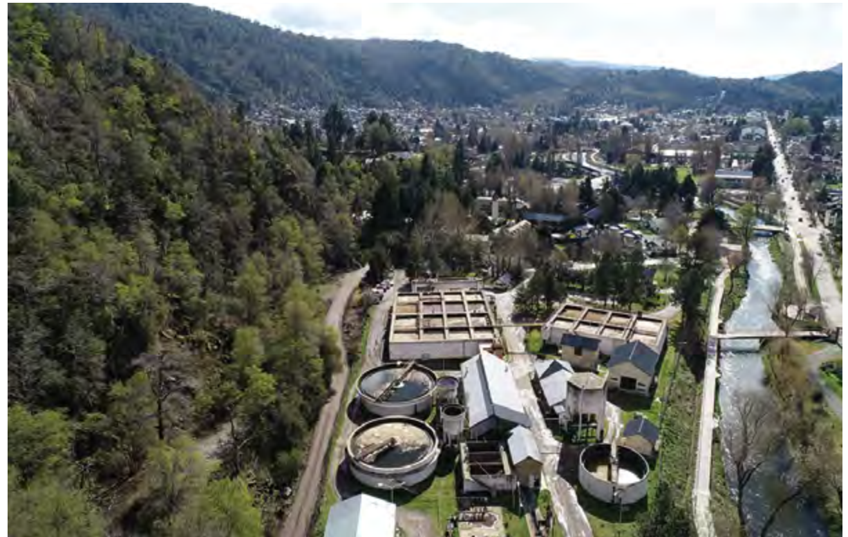
Foto N° 17. Planta de Tratamiento de Efluentes.PT1
