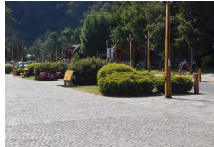
Foto N°23. Incorporación de islas de bio infiltración
